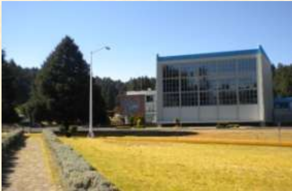
Edificio del reactor y reactor en operación a 1 MW
